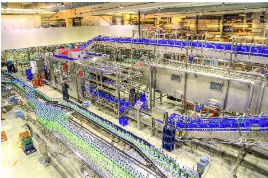
Neue Glas-Mehrweganlage in Eilenburg in Betrieb (© Kai Barholz/FRANKEN BRUNNEN GmbH & Co. KG)
